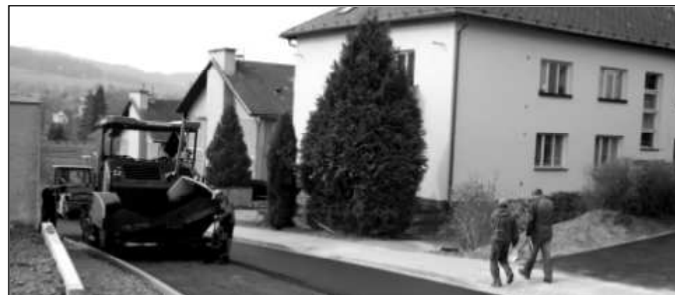
POKLÁDKA ASFALTOVÉHO POVRCHU PROBĚHLA 2. LISTOPADU 2013
