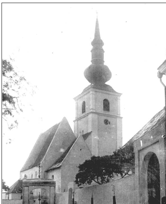
DOBOVÝ POHLED NA KOSTEL, KTERÝ MÁ JEŠTĚ PŘÍSTAVEK U HLAVNÍHO VSTUPU
