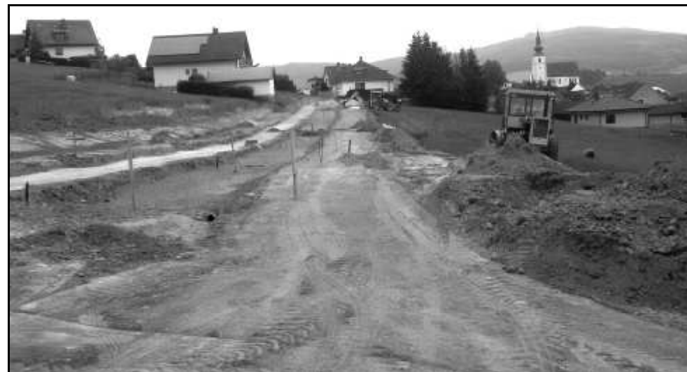
STAVEBNÍ PRÁCE NA SVAHU VINNÉHO VRCHU JSOU V PLNÉM PROUDU
