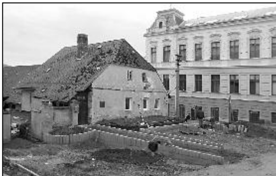
PARKOVACÍ STÁNÍ VE VÝSTAVBĚ
