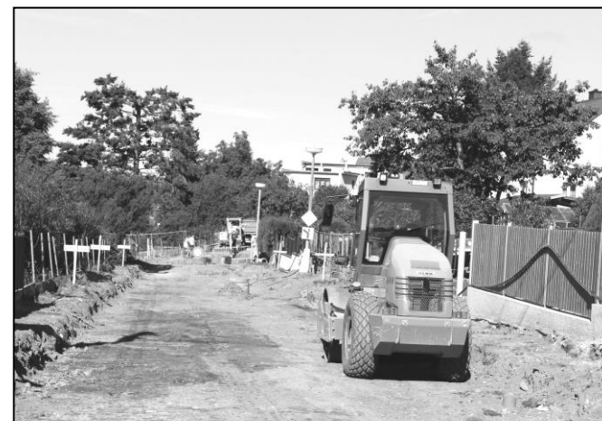
PŘÍPRAVA KONSTRUKČNÍCH VRSTEV KOMUNIKACE
