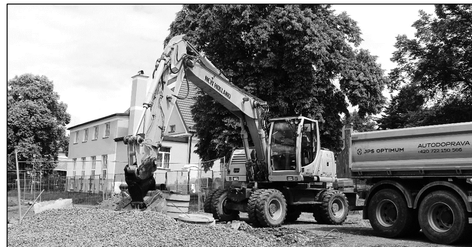
NYNÍ PROBÍHAJÍ STAVEBNÍ PRÁCE NA REKONSTRUKCI KANALIZACE
