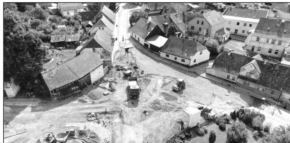
LETECKÝ POHLED NA STAVENIŠTĚ U SOKOLOVNY
